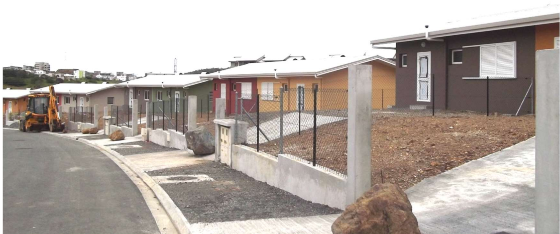
Pavillons tropicaux, Lotissement Brigitte, Dumbéa sur Mer
